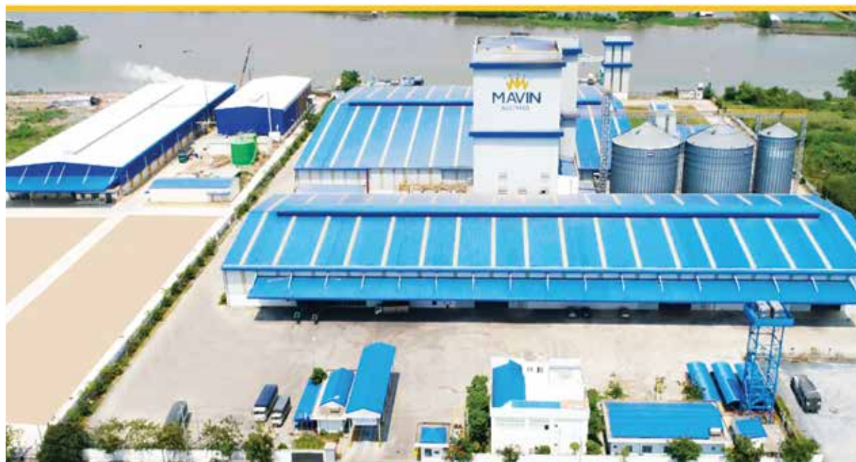
Hệ thống mái Skylight tại Nhà máy Mavin Austfeed Đồng Tháp
